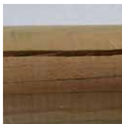
Cracks/Grietas/Fente/Risse/ Crepe/ Barsten/Fendas
